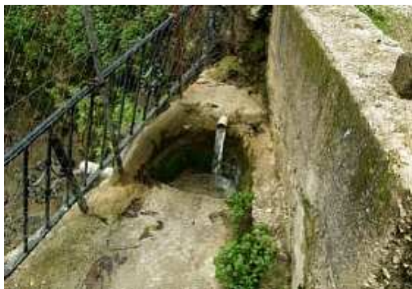
Detalle del caño inferior, que llena la alberca anexa (A.Vela Torres, octubre, 2008)
