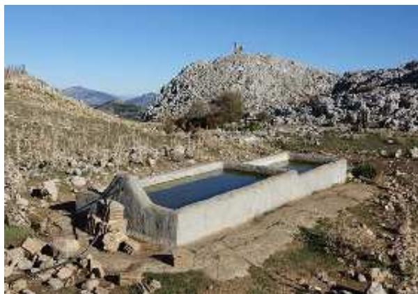
Abrevadero y Torre de Lifa (M. Limón Andamoyo, diciembre 2017)
