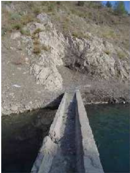
Entrada del túnel, cegada en la actualidad (C. Sánchez Argüelles, junio 2017)
