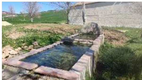
Pilar del Arroyo de La Dehesa, en la actualidad (S. Caballero. marzo 2024)
