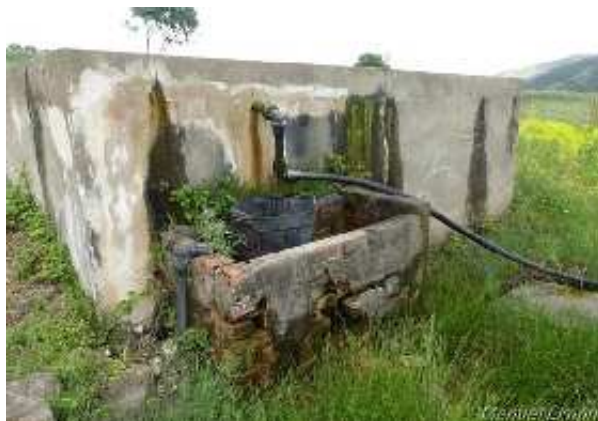
Aljibe de San Carlos del Tiradero (M. Limón Andamoyo, mayo 2017)
