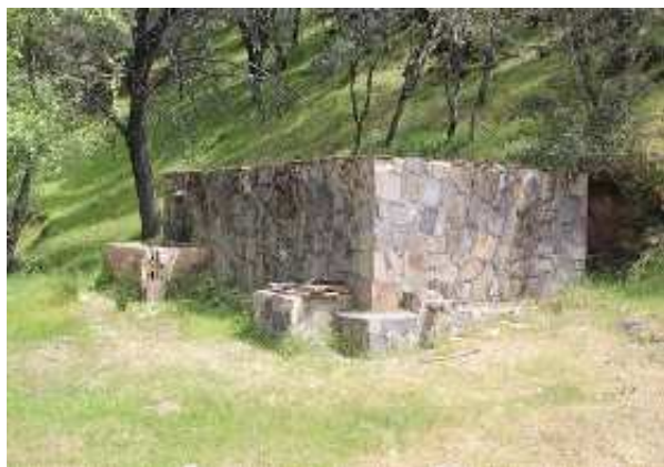
Fuente y aljibe del Arroyo del Batán (J. A. Palomino León, abril 2017)
