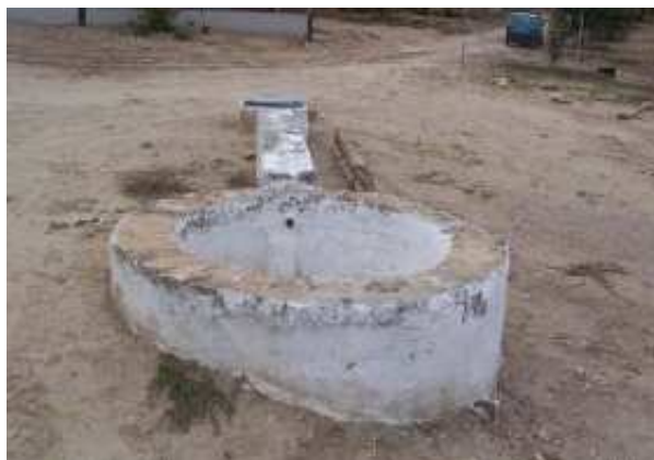
La Fontanilla, vista de la canalización y la pileta (J.M. Jiménez, J. Jiménez y M.J. Ruiz, octubre 2008)
