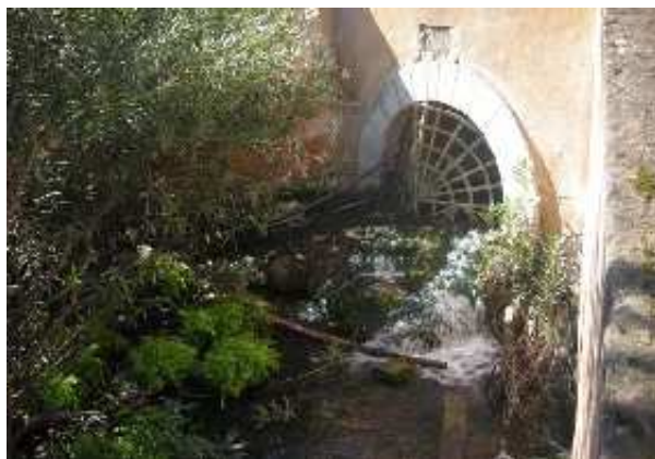
Socavón de las Minas (L. Sánchez Díaz, febrero 2017)
