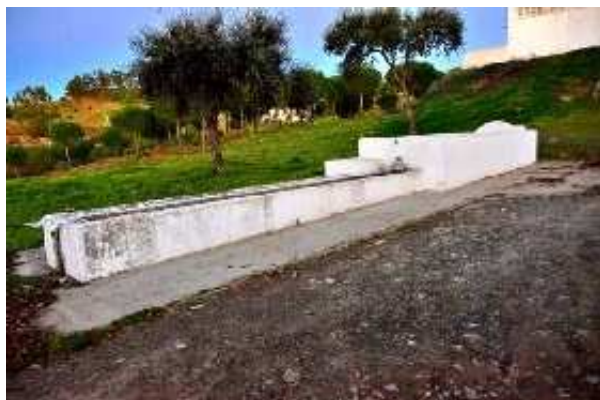
Pilar de la Juncarilla (J. Torres Garrido, diciembre 2016)
