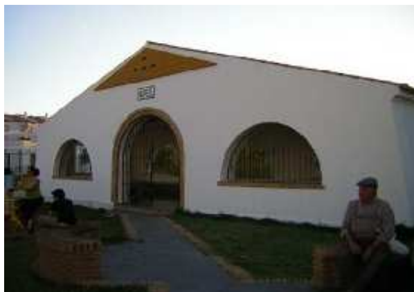
El lavadero de El Almendro (Wikanda.Huelvapedia, agosto 2009)
