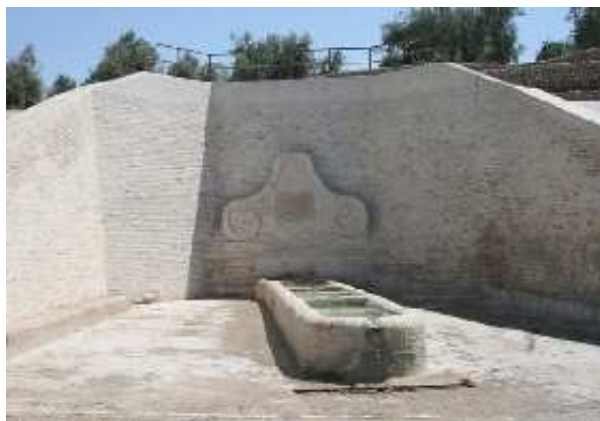
Fuente del Pilar, restaurada (M. Cala, agosto 2008)
