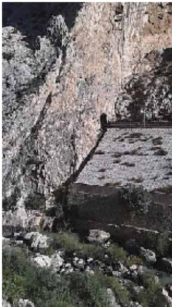
Manantial del Túnel del Tajo de Gaitán M. Sánchez "Pérez, noviembre 2016)
