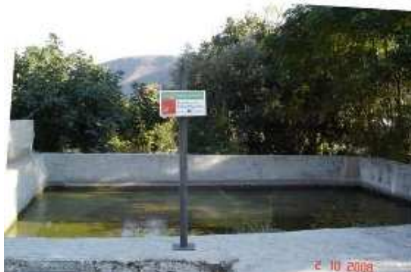
Fuente de El Cortijuelo.- Balsa de acumulación (J. Martín Jiménez, octubre, 2008))
