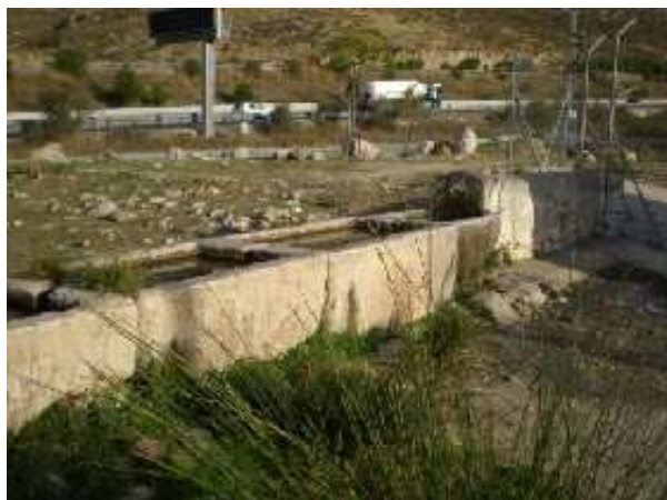
El caño y las primeras pilas de la fuente; detrás está la autovía A-45 (A. Vela Torres, octubre, 2008)
