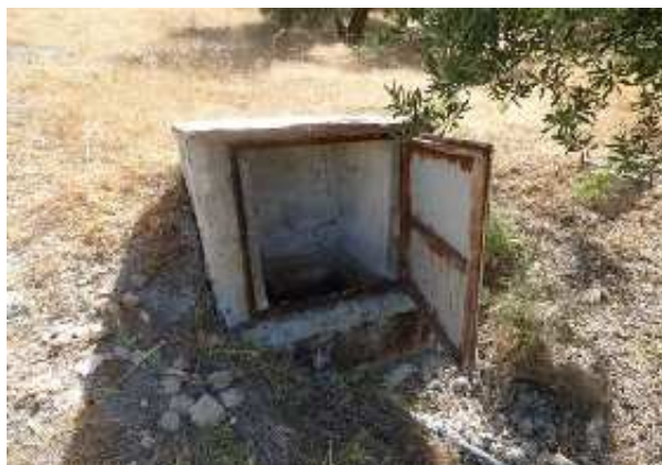
Fuente de la Loma Extremera, arqueta (J. D. Cano Cavanillas, agosto 2016)
