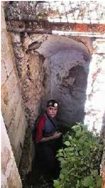
Iniciando bajada a la mina (J. M. Ramos González, mayo 2016)
