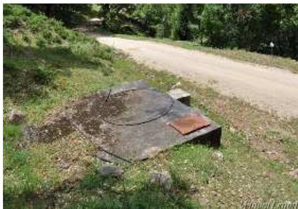
Depósito de Bañuelos (M. Limón Andamoyo, mayo 2016)
