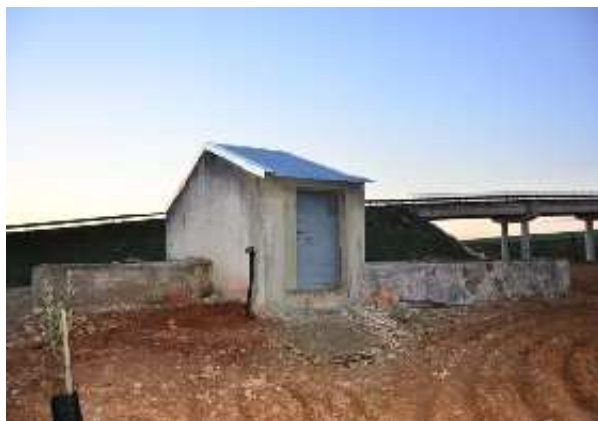
Pozo del Cortijo de Traba (J. Torre Garrido, marzo 2016)
