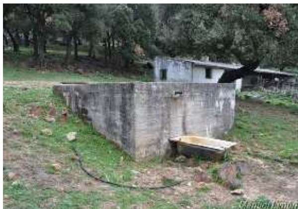
Fuente de la Cancha, depósito (M. Limón Andamoyo, abril 2016)
