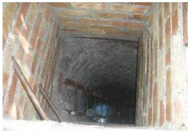
Fuente de San Antonio, interior del pozo (L. Sánchez Díaz, abril 2016)
