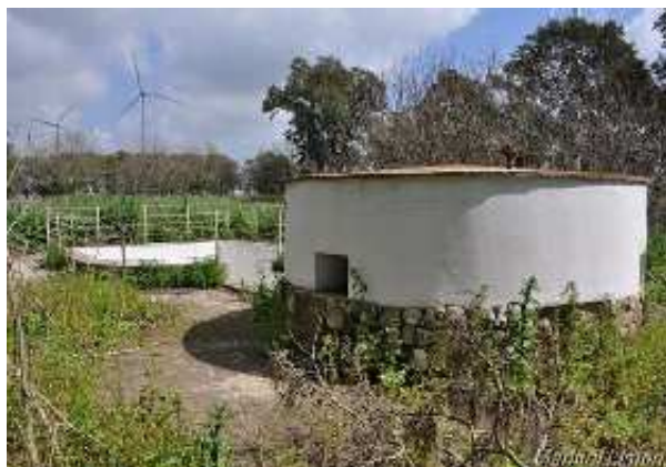
Pozo de Malas Noches II (M. Limón Andamoyo, marzo 2016)
