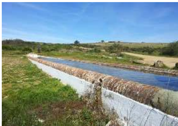
Pilar Nuevo (A. Domínguez Luengo, marzo 2016)
