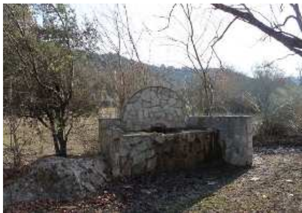
Pilarillo del Puente (T. Peinado Parra, enero 2016)
