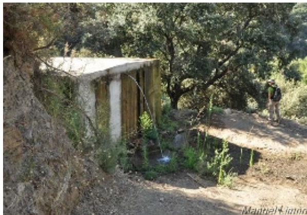
Fuente de la Fábrica (M. Limón Andamoyo, enero 2016)
