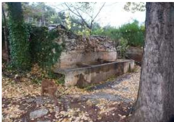
Fuente de La Pendolera (L. Cano Cavanillas, noviembre 2015)
