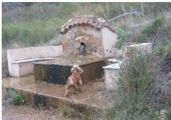
Fuente del Viznagal de Arriba (L. Cano Cavanillas, noviembre 2015)
