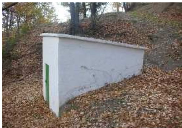
Manantial del Barranco de Cádiar (L. Sánchez-Díaz, noviembre 2015)
