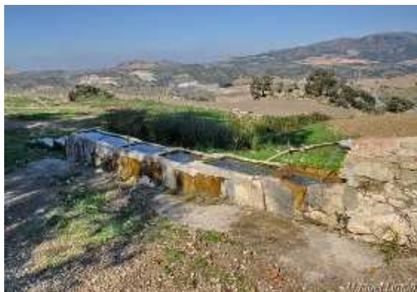
Fuente de Carastas (M. Limón Andamoyo, noviembre 2015)
