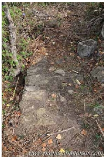
Resto de muro del Pilón (M. Limón Andamoyo, octubre 2015)
