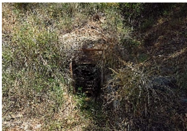
Mina del Lagar de la Purísima Concepción, bocamina (A. Vela Torres, mayo 2015)
