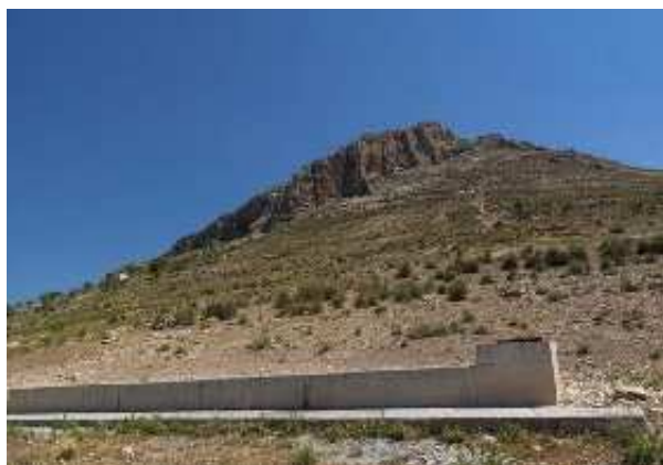
Abrevadero de la Cañada de la Torre con El Mencal al fondo (J. Rubia, mayo 2015)
