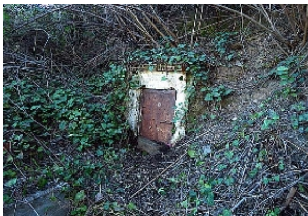
Mina del Lagar del Estanquero (A. Vela Torres, marzo 2015)
