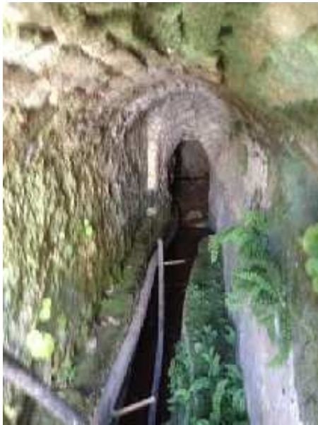
Imagen de la mina original con una conducción de plástico moderna para facilitar el transporte (J. M. Fernández-Palacios, mayo 2015)
