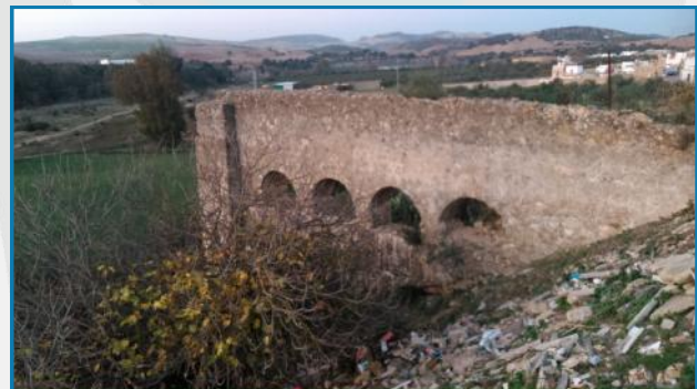
Acueducto de la Molineta (Puerto Serrano, Cádiz) Juan Jesús Portillo Ramos (diciembre, 2015)
